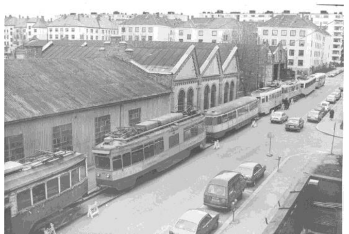
I 1983 flyttet LTF inn i Vognhall 5, og hallen fikk igjen noe av sin opprinnelige funksjon, nemlig å huse sporvogner. Foto: Ole Mjelva
