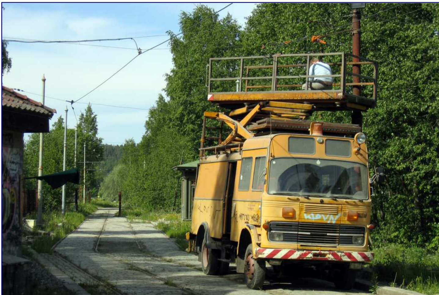
Espen Norman Røe arbeider med kjøreledning på ledningsbilen på Vinterbro 28. mai 2008. Foto: Håkon Kinck Gaarder.
